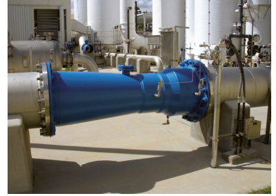
الشكلُ (33): مقياسُ فنتوري في إحدى محطاتِ المياهِ.
